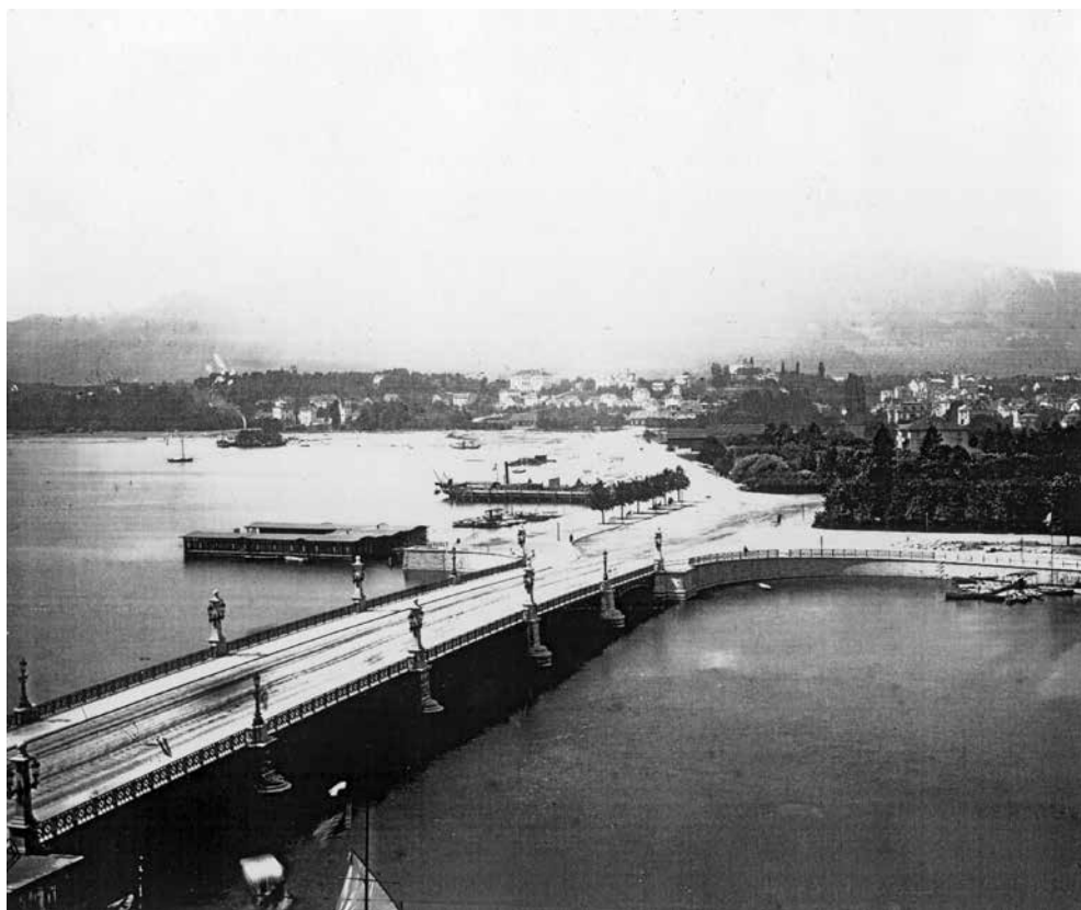
Die Quaibrücke steht 1884 vollendet da, die Männerbadeanstalt ist errichtet, und die Dampfschiffe können anlegen. Dahinter gehen die Auffüllarbeiten für den Bau des Alpenquais, des heutigen General-Guisan-Quais, unvermindert weiter. Bild: Schmid, 1884/Archiv AGZ
