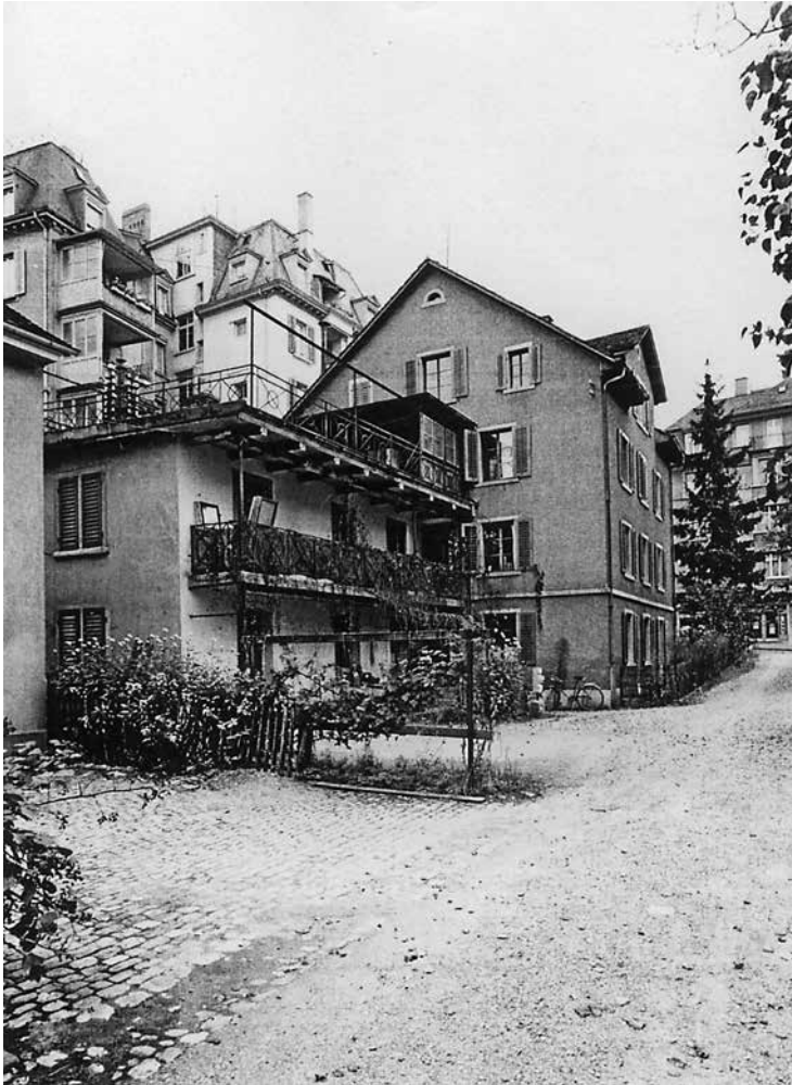
Das 1874 errichtete «Magdalenenstift» an der Eidmattstrasse 21 in Hottingen wurde 1877 erweitert und 1967 abgetragen. Bild: Baugeschichtliches Archiv der Stadt Zürich
