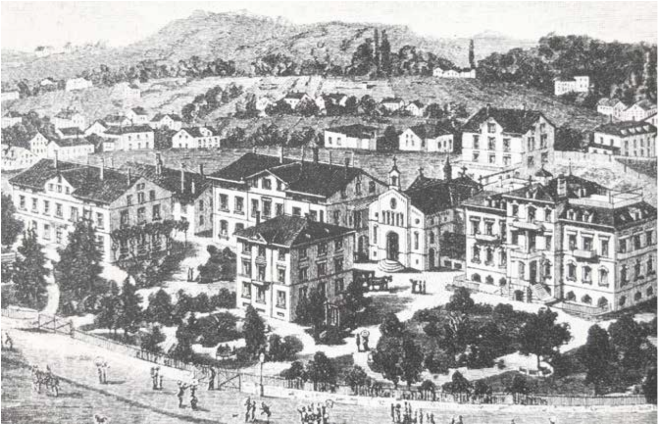
Die GGN erwirbt 1931 die Liegenschaft der Kranken- und Diakonissenanstalt Neumünster zwischen Forch- und Minervastrasse.
