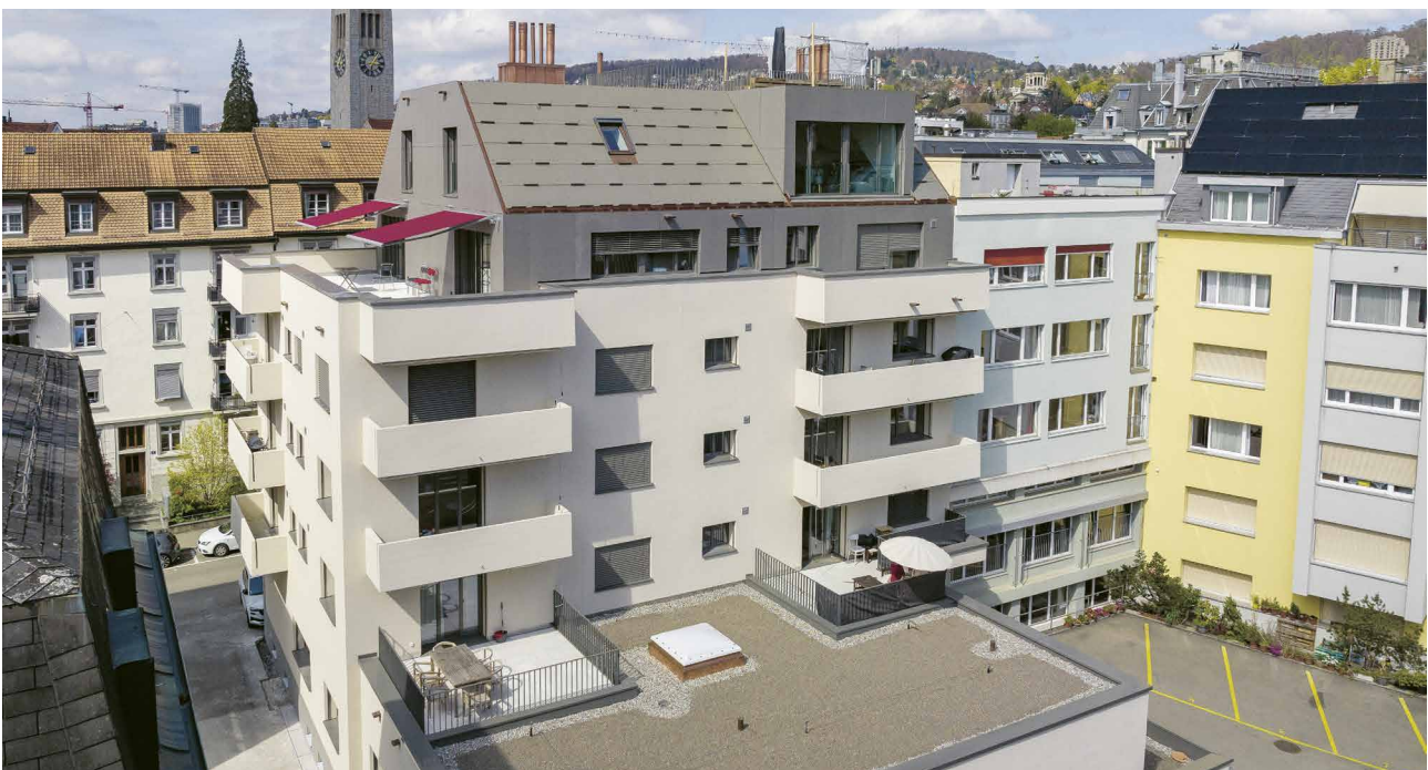
Das sanierte Gebäude Eidmattstrasse mit dem neuen, markanten Dachaufbau
